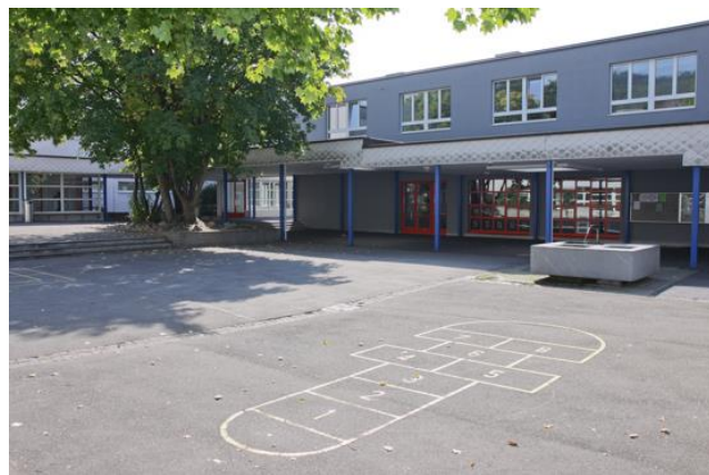
Schulhaus Unterboden, hier befindet sich Ihr Arbeitsplatz!
